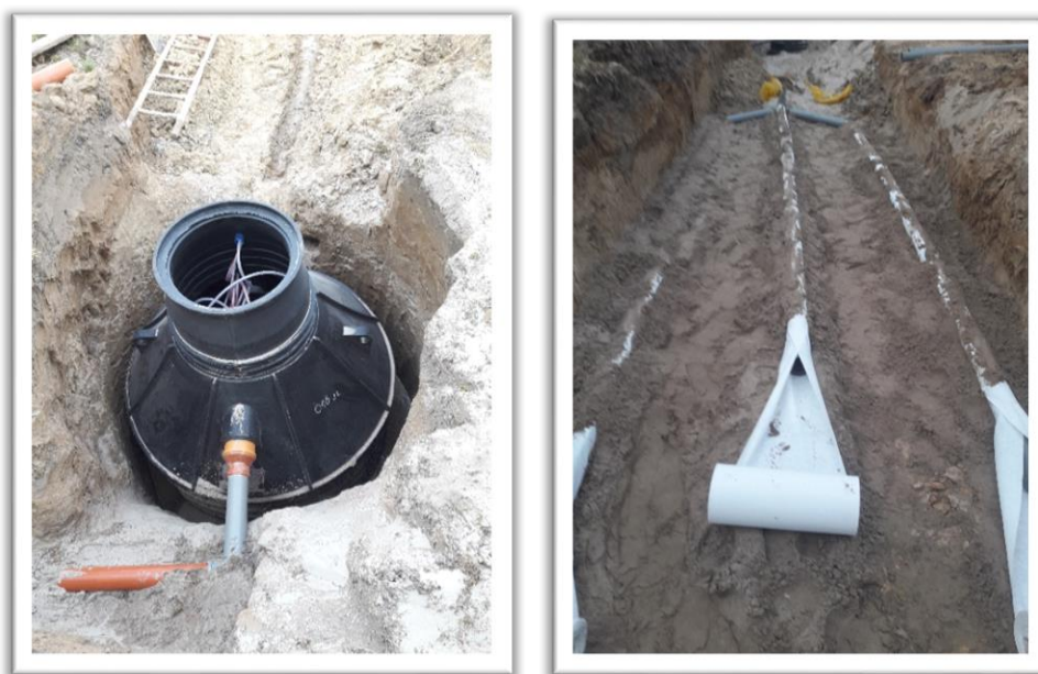
Montaż przydomowej oczyszczalni ścieków
