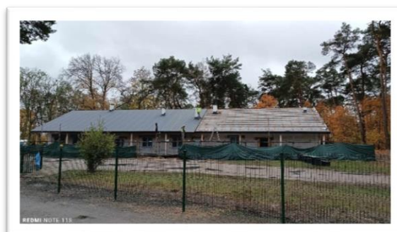
Budowa budynku socjalno-sportowo-rekreacyjnego na stadionie sportowym w Łabiszynie
